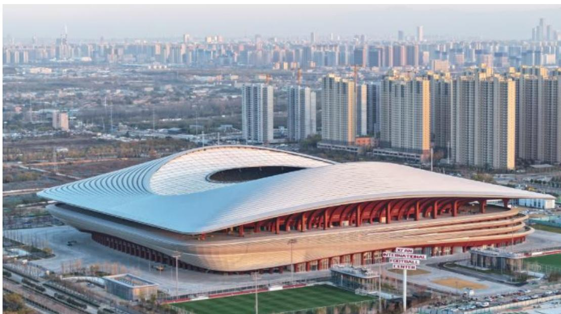
西安国际足球中心位于沣东新城大西安新中心轴线核心位置，项目占地280亩，总建筑面积25.1万 $\text{m}^2$ ，包含一座固定座席6万座的专业足球场及两片标准室外训练场，主场馆建筑高度63.9 m，地上6层，地下1层，是按照国际足联和亚足联最新标准设计建造的一座甲级专业足球场馆，建成后可以承接世界杯在内的全部国际顶级足球赛事。
